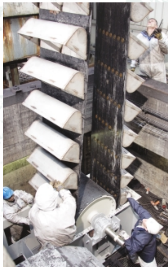
Unser Servicepersonal bei der Montage eines Gurtbecherwerkes.
